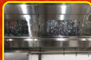
104.10.21完成改善午餐 廚房設備工程
