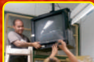
104.11.25完成教室廢棄 電視拆除作業
