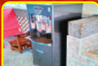
104.09.11完成改善飲用 水設施工程
