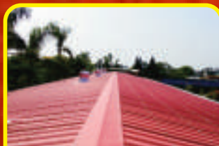
104.11.13完成屋頂防水 隔熱改善工程
