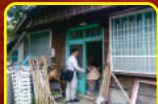
104.11.26完成G棟宿舍 耐震詳評初評
