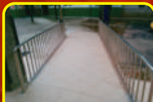
104.12.01完成幼兒園坡道 及扶手改善無障礙改善工程
