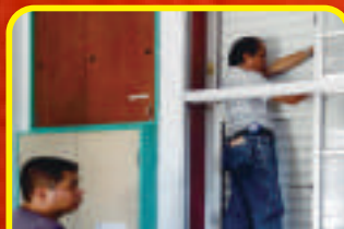
104.11.18完成教室百葉 窗修繕
