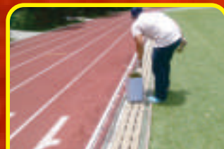
104.12.02完成人工草皮 路緣石修繕作業
