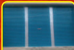
104.10.20完成廚房鍋 爐室鐵門改善
