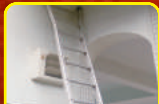
104.11.13完成司令台 積水疏浚改善
