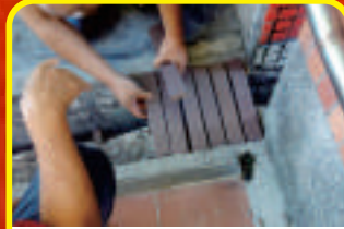
104.11.07完成音樂教室 前漏水改善工程
