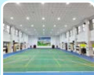
113.1.25室內足球場地墊工程完工
