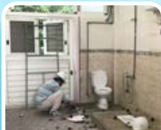
113.4.9東大樓廁所整修工程
