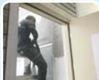
113.2.20資源班壁癌修繕工程
