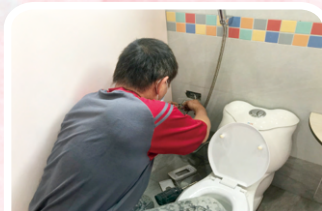
112.5.2幼兒園廁所緊急鈴修繕
