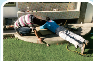
112.2.28幼兒園洗手台漏水修繕
