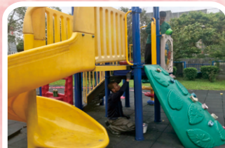
112.4.27南側遊戲場修繕
