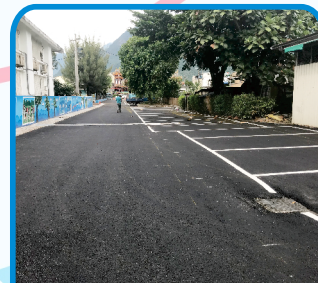
111.09.20地坪改善工程 完工驗收
