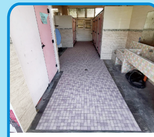
112.01.04東大樓廁所 地磚修繕完工
