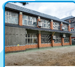
111.9.20西大樓防水 隔熱工程完工驗收
