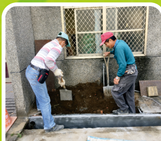
1110530活動中心水溝修復
