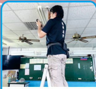
110.8.19消防設備檢修
