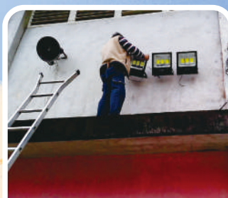
110.02.05籃球場裝設夜間照明
