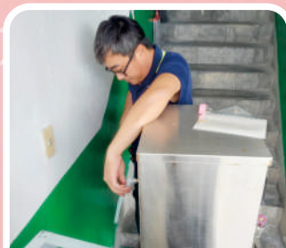
110.04.20東大樓2F飲水機維修
