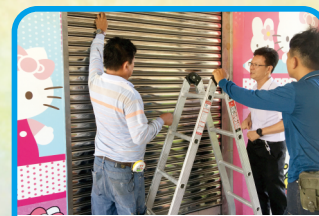
109.9.18裝設廁所 鐵捲門
