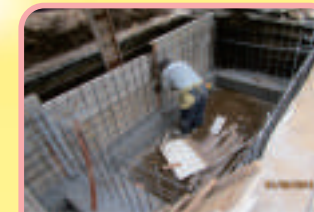
102年6月北車道地面積水改善工程施工
