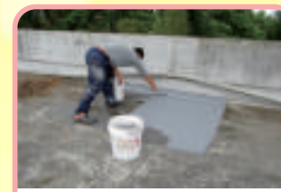
東大樓教室屋頂防漏工程施工作業
