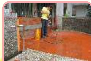
清洗西大樓樓梯
