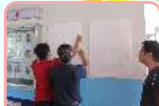
西川堂布告欄施作
