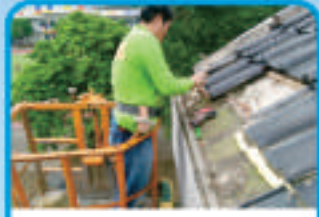
修繕西大樓屋頂破損
