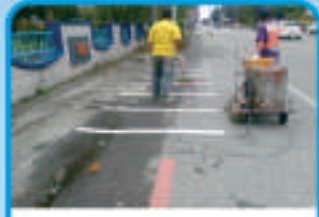
西大門圍牆外停車格施作
