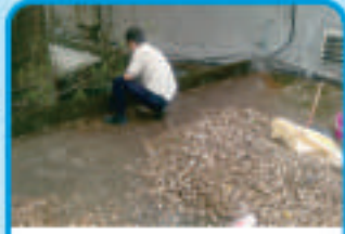
屋頂定期清淤整理
