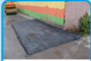
停車安全改善設施工程
