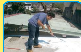
替代役男宿舍牆壁粉刷 及屋頂清洗整理
