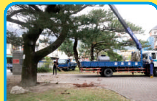
完成東大樓樓板漏水 修繕
