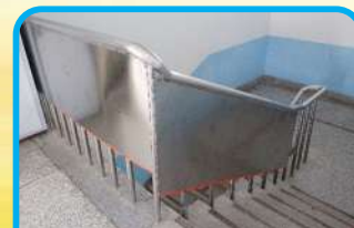
樓梯間加設欄杆防護
