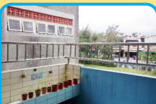
洗手台加設欄杆防護
