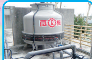
105.03.01體育館空調 設備工程
