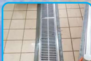
105.04.05-廚房排水 溝更新
