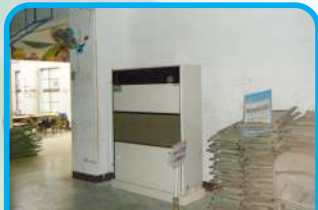
105.03.01體育館空調 設備工程-內機部分
