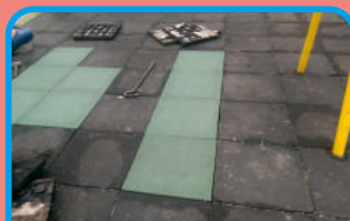
完成籃球場鋪面整修保固
