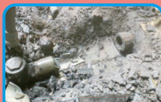
完成東大樓樓板漏水修繕
