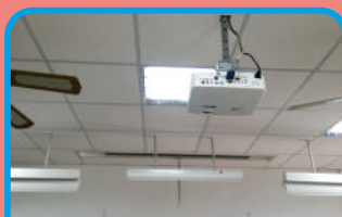
完成北大樓校舍防水隔熱改善工程
