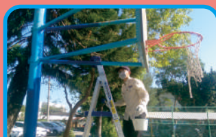
完成遊戲器材暨校園四周圍牆油漆保養
