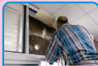
東大樓廢棄空氣濾清器移除與窗玻璃復原
