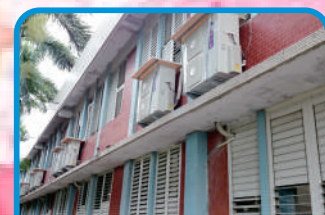
教室噪音防制改善工程-室外機裝設
