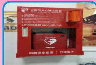
完成自動體外心臟去顫器 (AED) 設備工程
