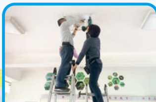
108.03.30校園夜間照明施工
