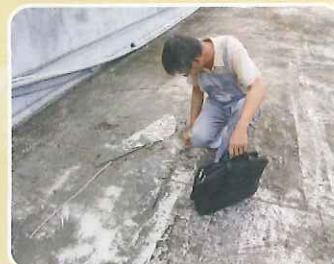
防水處理技師至教學大樓屋頂檢查
