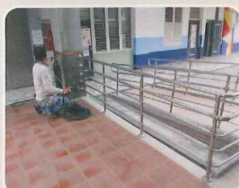
志工爸爸主動維修無障礙扶手
