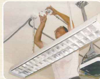
消防設施檢修-偵煙探測器更新
