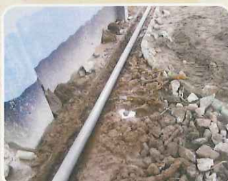
改善幼兒園四周水溝排水
