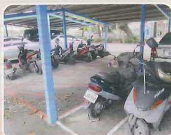
停車棚整修(停車格位重劃與油漆)
