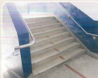
教學大樓無障礙設施改善(扶梯、不銹鋼止滑)
