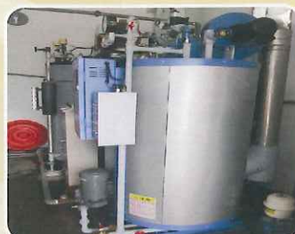
更新廚房瓦斯鍋爐，提供學童穩定午餐供應
